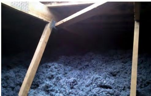
Métisse® Flocon est destiné à l'isolation thermique et acoustique par soufflage :
