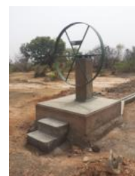
Forage à Diébougou
