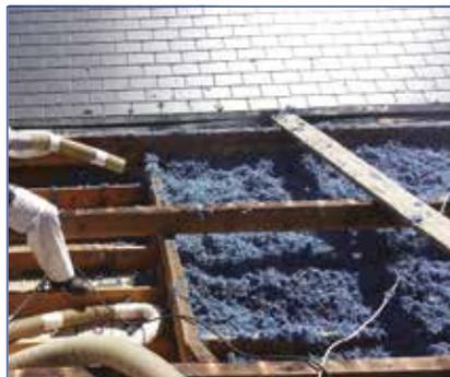
Le matériau est mis en oeuvre par soufflage pneumatique sur la surface d'un plancher ou entre solives ou solivettes, ou sur le plafond suspendu type plaque BA13.
